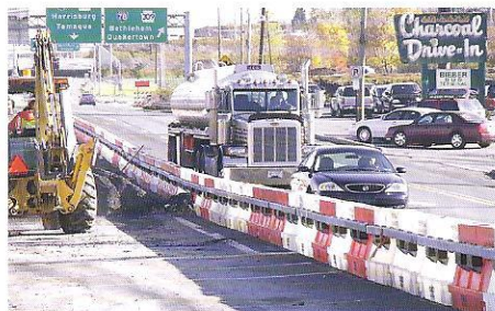
Longitudinal Barrier Wall
